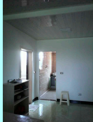
Boven: de onbewerkte woonkamer. Midden: de afwerking van het plafond. Onder: de woonkamer.
