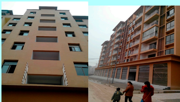
De nieuwe flat is op de 5 e etage.
