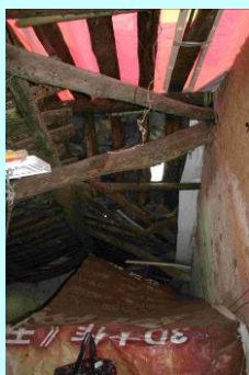
Dak provisorisch gerepareerd met zeil
